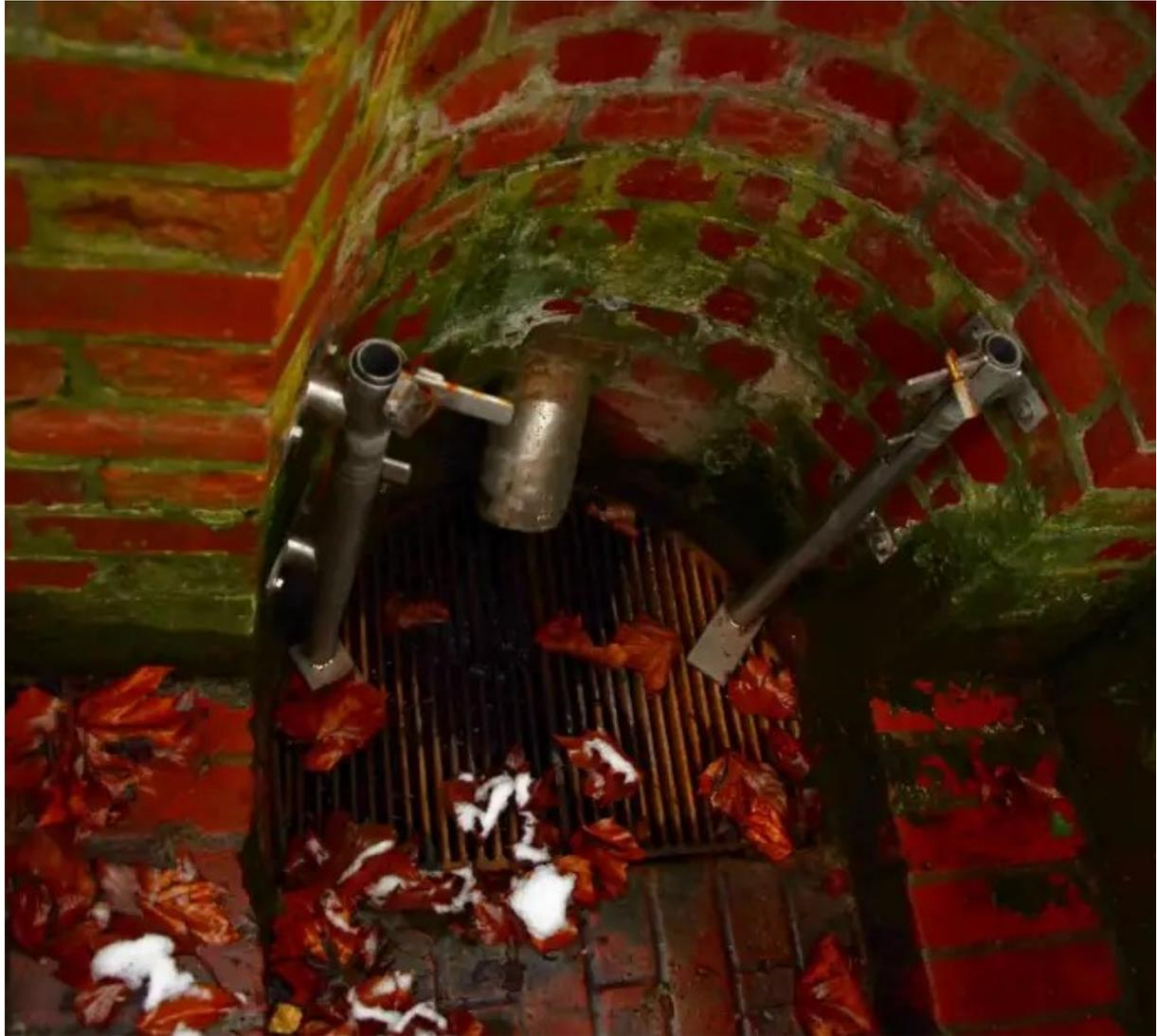
Am Grund befindet sich eine mit einer Nische versehene gemauerte Quelfassung mit einem Edelstahlrohr, aus dem sich das Wasser in ein kleines Becken ergießt.
