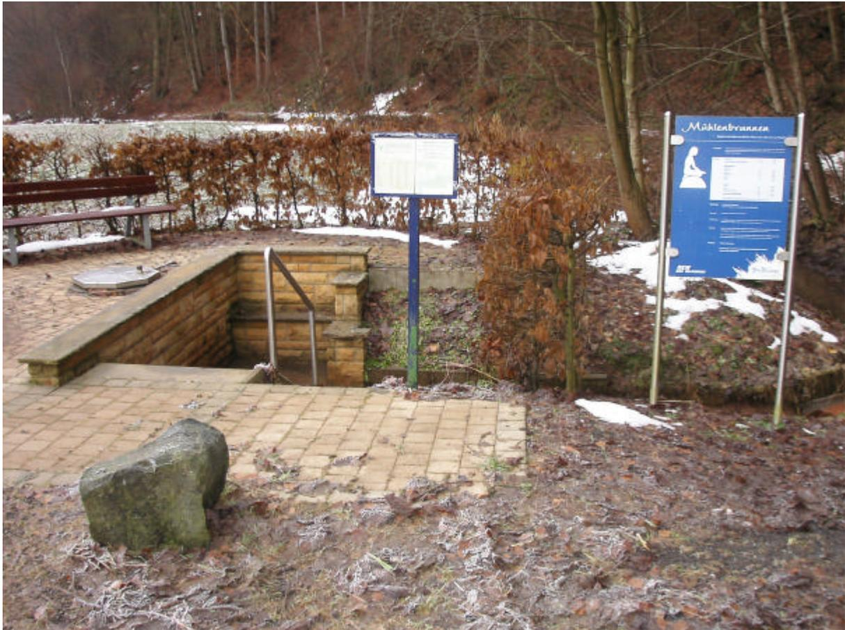
Der Mühlenbrunnen liegt an der Wiesenmühle im südwestlichen Teil Kleinerns. 1954 wurde die Holzfassung durch eine 9m x 5m große Filterkiesgrube mit Tonabdeckung ersetzt. 2007 wurde die gesamte Quellanlage saniert und neu gestaltet.
